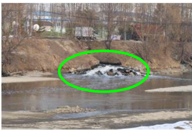
조사하천 하류지역 정화수 배출 전경
