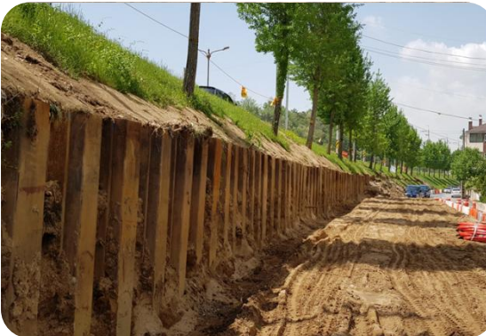
SHEET PILE 공법
