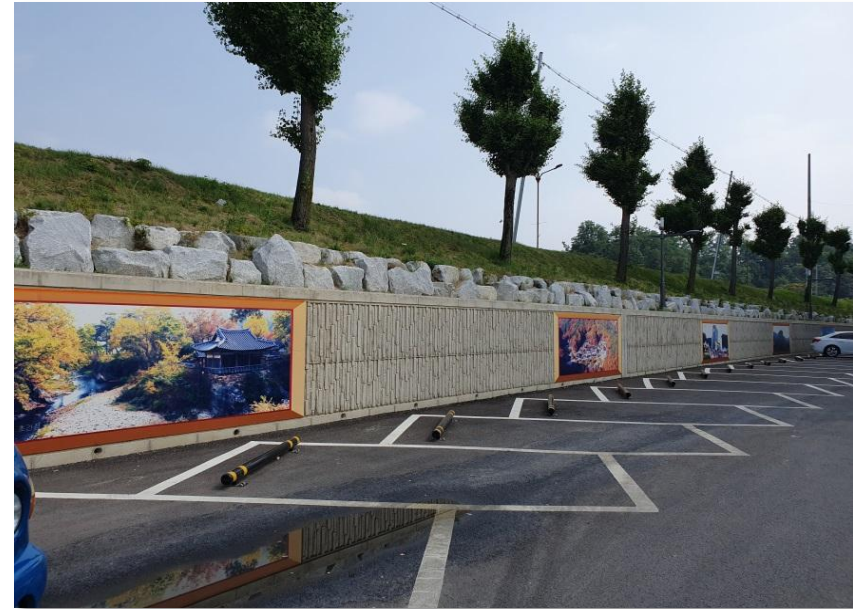
주차장 조성 후(주차면수: 154대)
